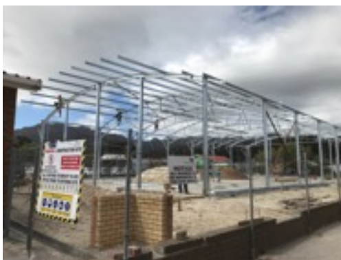
Mitte Oktober: das Gerüst ist erstellt
